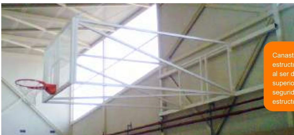
Canasta abatible de 2,50 mts colocada entre cerchas mediante estructura metálica soldada a las mismas, a su vez, debido al ser de mayor vuelo de 1,50 mts se le colocan unos tirantes superiores mediante cableado para dar más estabilidad y seguridad a la propia canasta. Tanto el cableado, como la estructura a la columna se presupuesta aparte.
