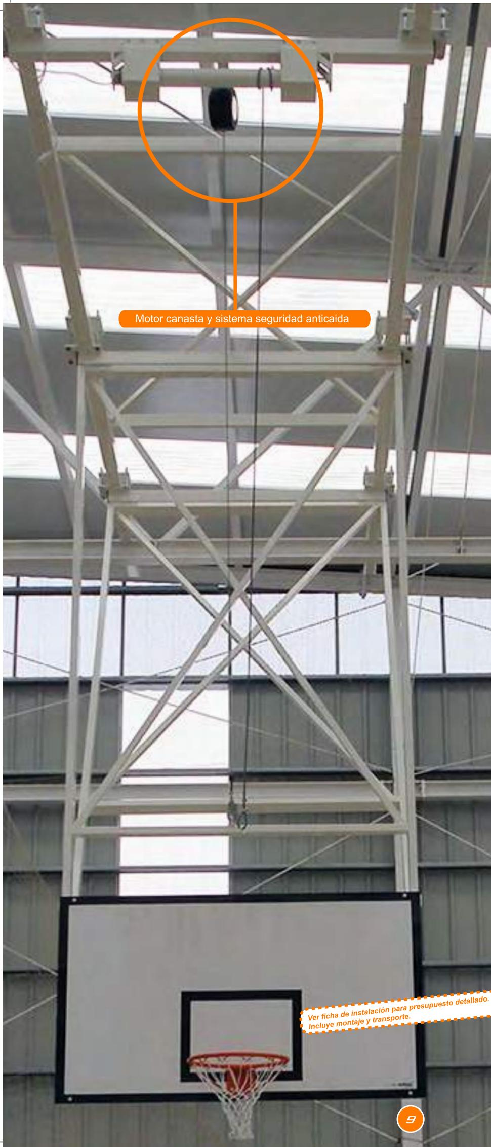
Motor canasta y sistema seguridad anticaida
